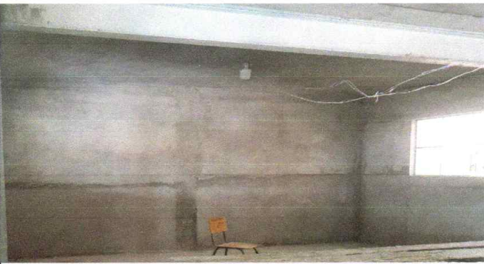
Foto 5: Repello en muro, para tres aulas del primer nivel
