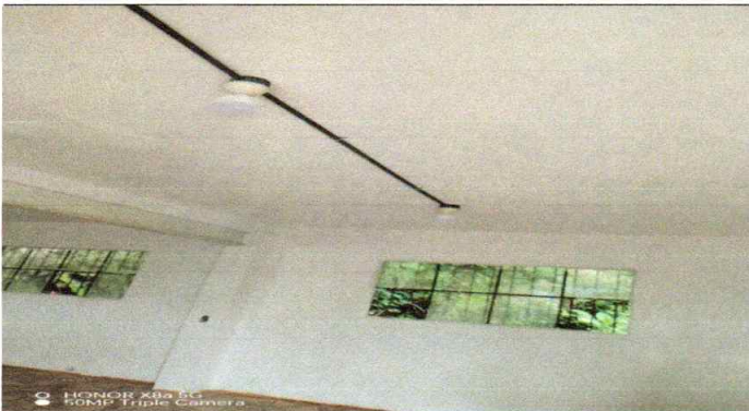
Foto 3: Sutitucion de plafoneras, de cuatro aulas del primer nivel de la escuela
