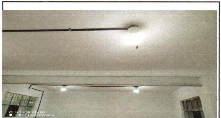
Foto 4: Sustitucion de focos ahorradores, de cuatro aulas del primer nivel de la escuela
