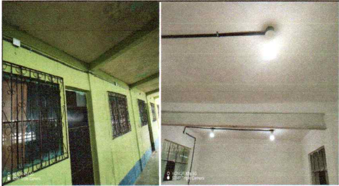
Foto 1: 1)Repación de cableado eléctrico, de cuatro aulas y corredor del primer nivel de la escuela.
