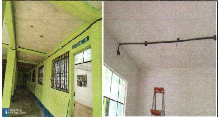
Foto 2: Sustitucion de ducto Electrico + accesorios, de cuatro aulas del primer nivel
