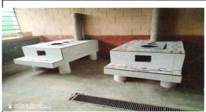
Foto 2: Sustitucion de dos estufas rurales completas, para la cocina del establecimiento
